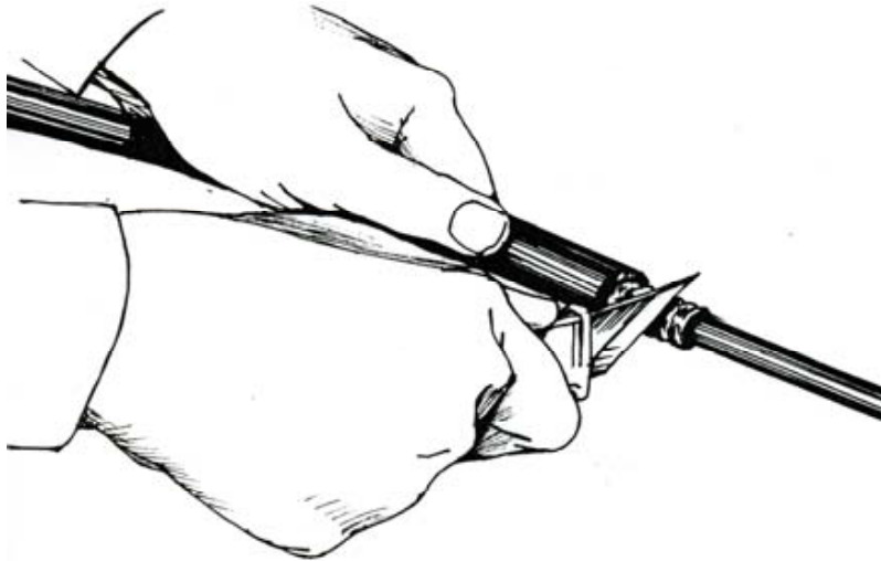
Рис. 3.1. Зачистка стальной гофрированной оболочки от полимерного покрытия
